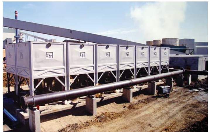
Una de las primeras Torres de enfriamiento Modulares hechas a mano con Fibra de Vidrio.
