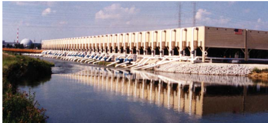
Instalacion de Torres de enfriameinto Modulares reduciendo la contaminacion térmica para ComED.
