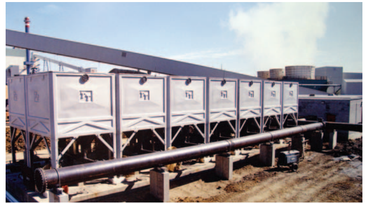
Una de las primeras Torres de enfriamiento Modulares hechas a mano con Fibra de Vidrio
